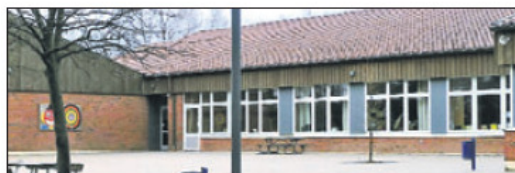
Modernisiert: die Grundschule in Steinbeck
